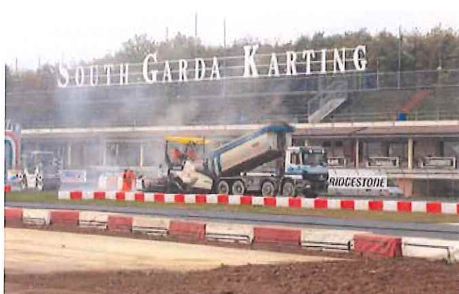
5A e 5B. L'attività di stesa del conglomerato bituminoso
