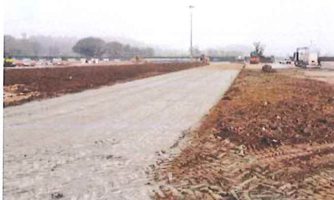
3A e 3B. La fase di spargimento del cemento e la stabilizzazione dello strato mediante una WR 250
