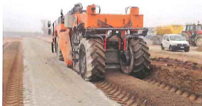
3A e 3B. La fase di spargimento del cemento e la stabilizzazione dello strato mediante una WR 250
