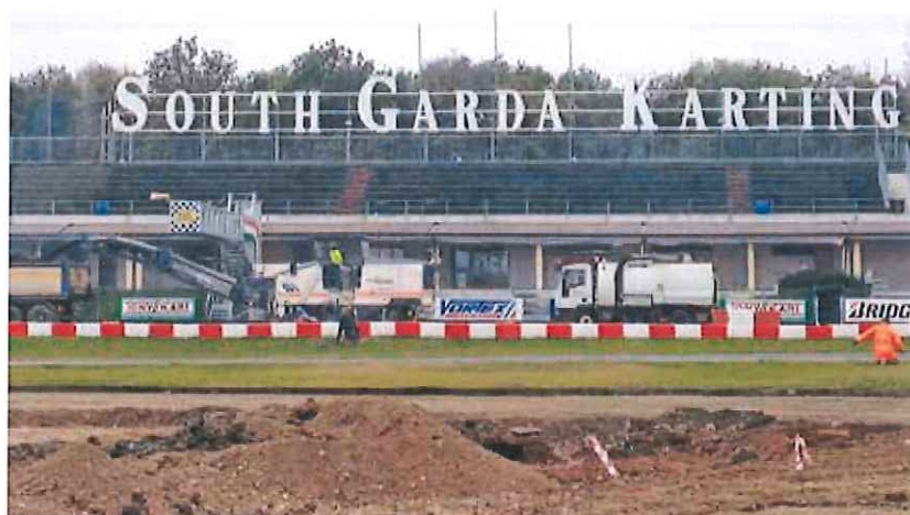
4. La fresatura del manto d'usura dello spessore di 3 cm mediante una fresa W200i
