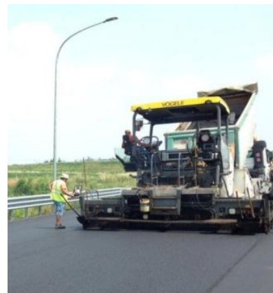
Un intervento firmato dalla Antonutti di Lonato sulla A21
